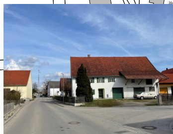
ortsbildprägendes Gebäude und Giebelparade entlang der Straße
